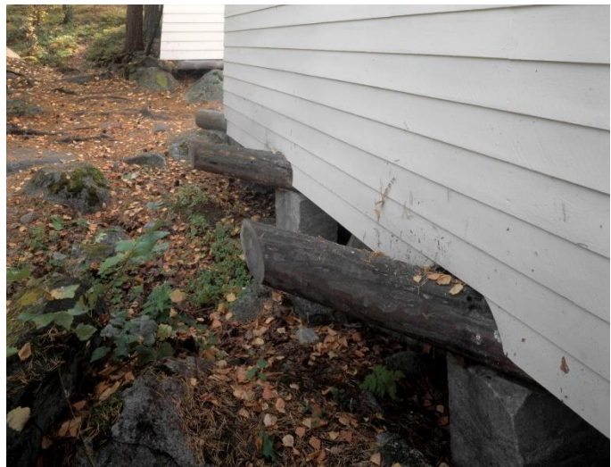
Figura 10: Cimientos Casa Experimental. Fuente: ver Tabla 18.
